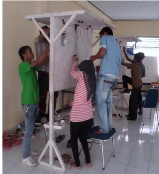
Gambar 4. Praktek Pemasangan Instalasi Listrik
