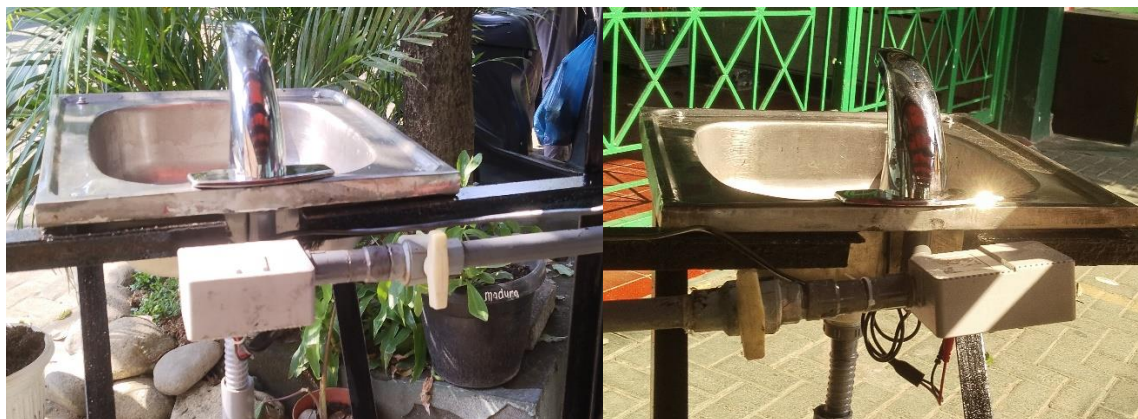
Gambar 17. Proses Akhir pemasangan kran elektrik
