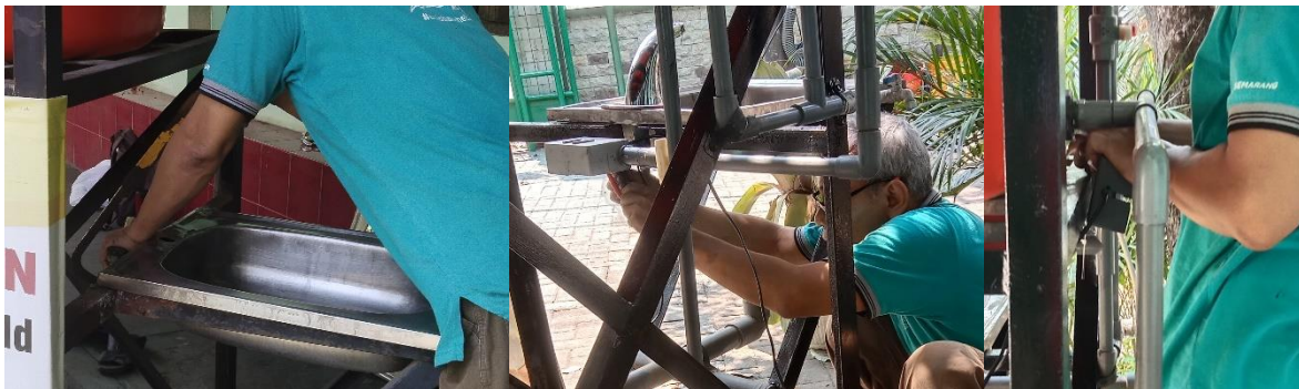
Gambar 16. Proses perakitan modul dan pemasangan peralatan
