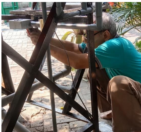
Gambar 7. Pemasangan Box valve
