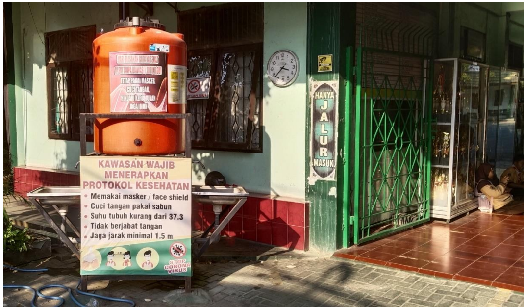
Gambar 15. foto tempat mencuci tangan sebelum dipasang elektronik kran
