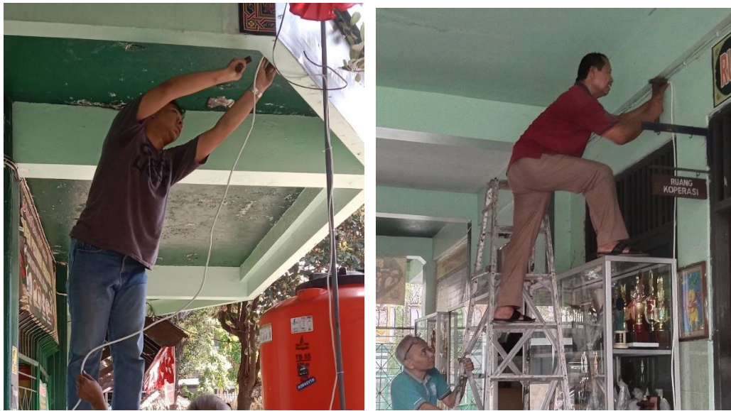
Gambar 9. Pemasangan jalur listrik untuk mencatu kran elektrik
