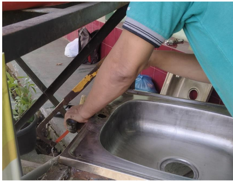
Gambar 5. Pelepasan wastafel
