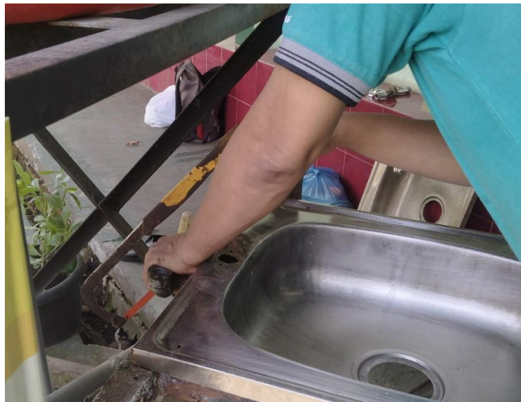
Gambar 5. Pelepasan wastafel
