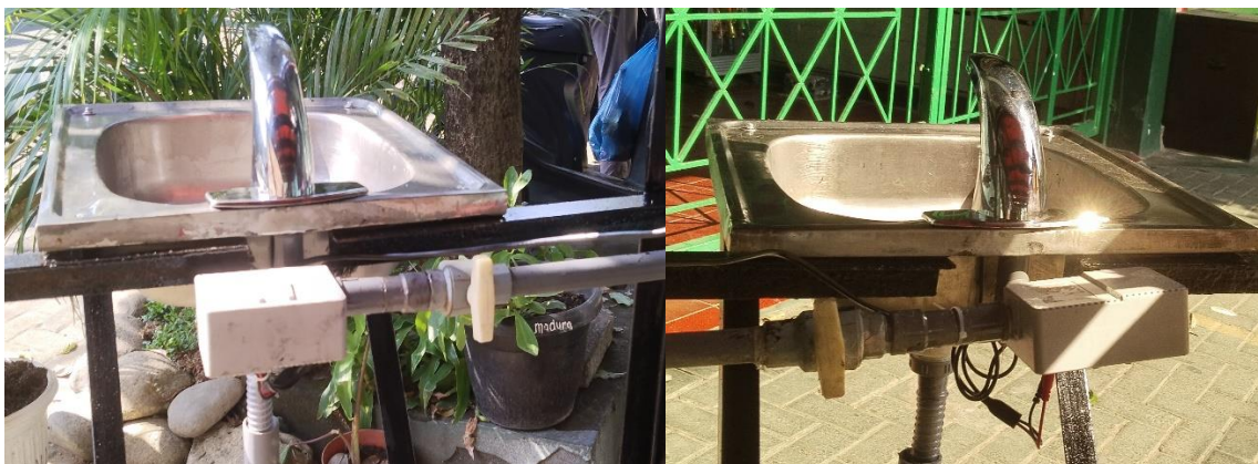
Gambar 17. Proses Akhir pemasangan kran elektrik
