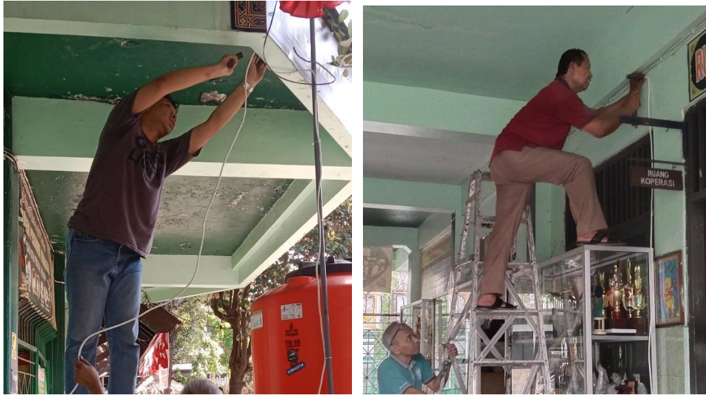
Gambar 9. Pemasangan jalur listrik untuk mencatu kran elektrik
