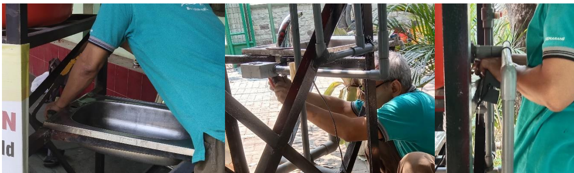
Gambar 16. Proses perakitan modul dan pemasangan peralatan
