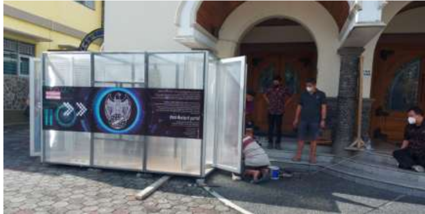
Gambar 3. Pemasangan Alat Desinfectant Portal
