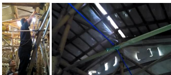
Gambar 6. Perakitan Uji Implementasi Sistem di Lokasi
